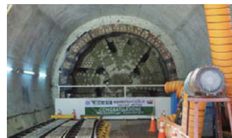
TBM1-2 メイ立坑到達
