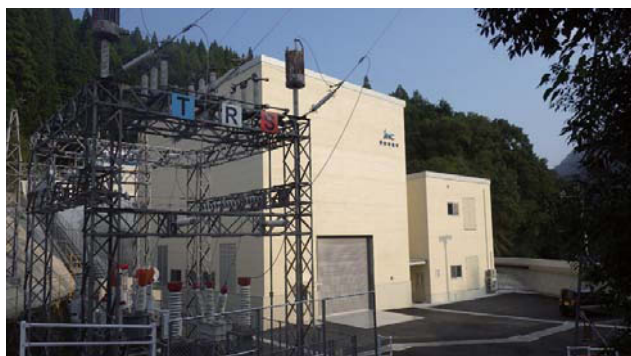
栗野発電所 リニューアル工事
