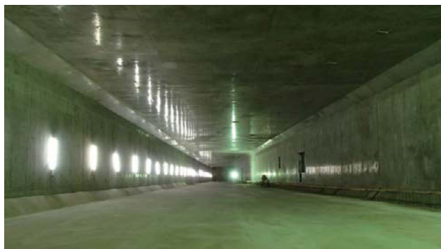
環2地下トンネル(仮称)築造工事(23ー環2新大橋工区)
