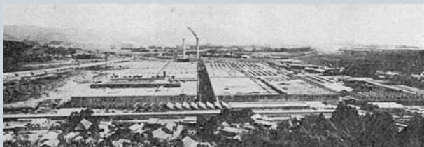
1930年(昭和5年) 延岡工場新築工事。
