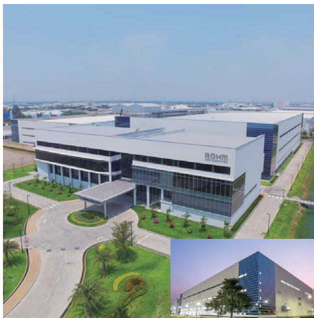
RIST新工場・厚生棟建設工事
