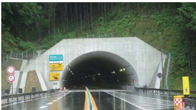
近畿自動車道紀勢線 周参見第二トンネル工事
