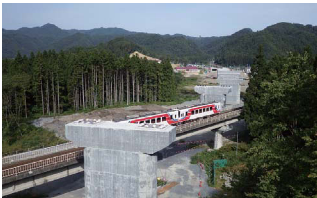
国道45号 小本道路工事
