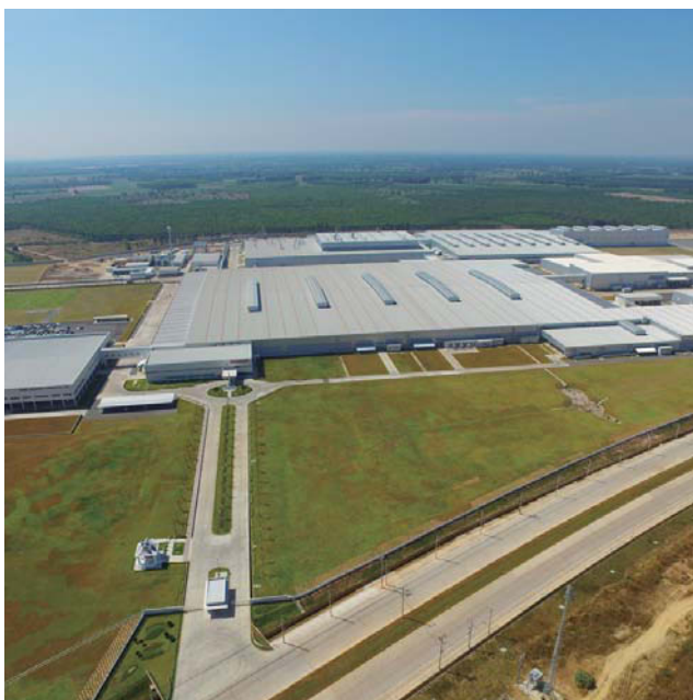
HATC新工場建設工事
