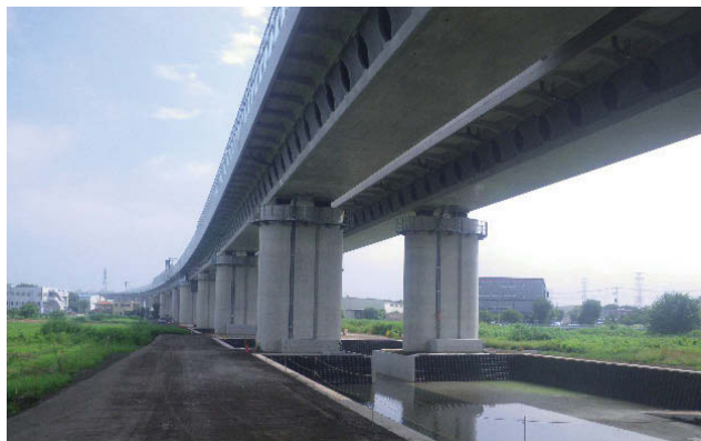
首都圏中央連絡自動車道 桶川第2高架橋(下部工)工事
