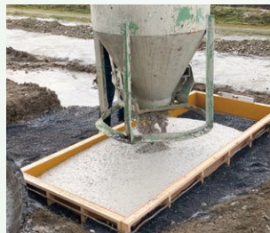
Placing (bucket)
