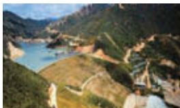
ロアシンマンダム
