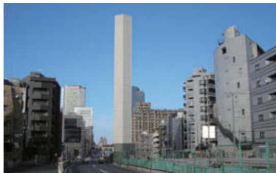
首都高中央環状線換気所
