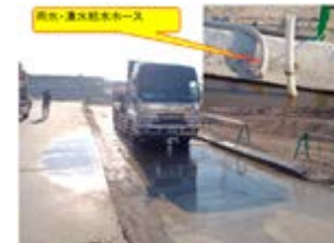
タイヤ洗浄プールの設置と雨水・湧水の活用による水道水の削減
