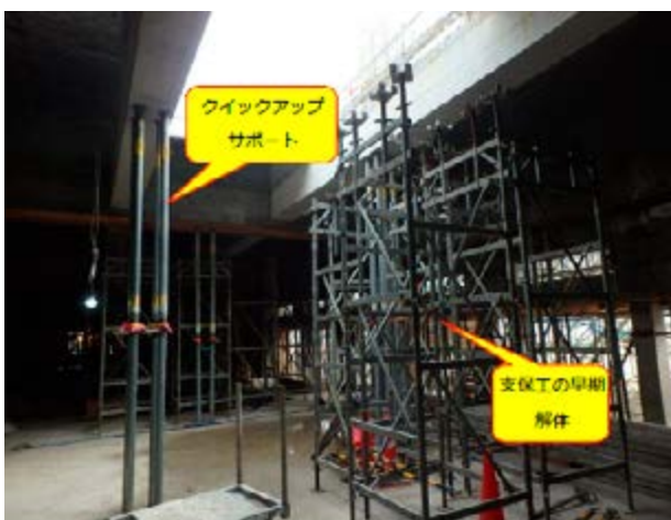
【省力化工法の採用（クイックアップ工法）】
