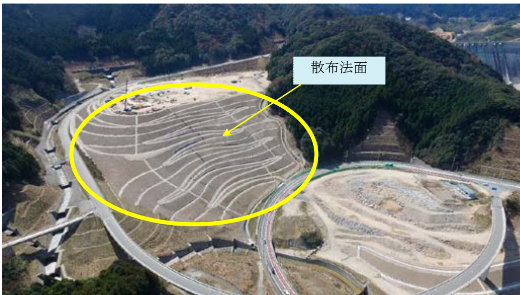
写真-1 土捨場全景
