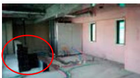
建築資材のプレカット化 (端材や残材の発生の抑制)
