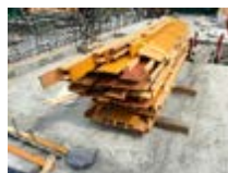
型枠材のパネル割上階への転用 (転用による余材の低減)
