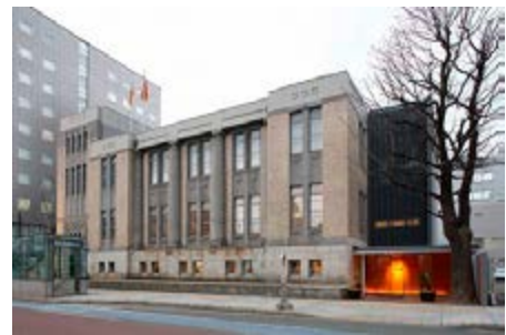
保存（リユース）した外壁
