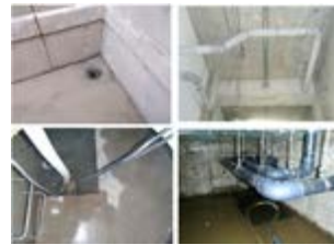
屋根雨水の中水再利用
