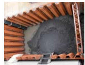
写真-2 一次処理土
