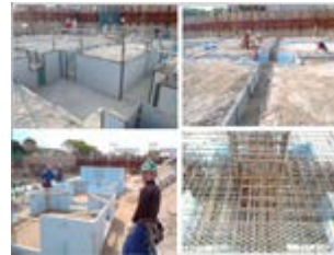
基礎工事において、鋼製型枠やスタイロ型枠を打込み型枠とし、発生土や埋戻し土の量を大幅に低減
