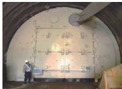
防音扉を設置
