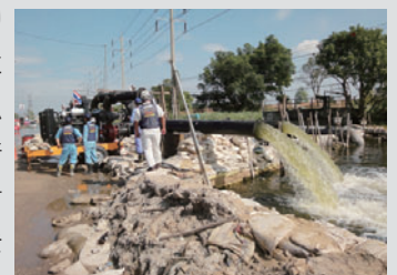
国際緊急援助隊による排水作業
