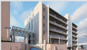
大阪初芝学園 北野田キャンパス および初芝キャンパス 竣工：2011年8月 所在地：大阪府堺市 用途：学校 延床面積：7,248.77m 2
