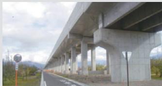
北陸新幹線小布施高架橋 竣工：2011年10月 所在地：長野県長野市
