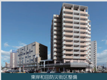
東岸和田防災街区整備
