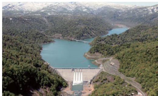
樺戸(二期)農業水利事業徳富ダム建設
