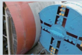
GFRGセグメント切削実証実験
