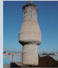
中間拡径場所打ちコンクリート杭(Me-A工法)
