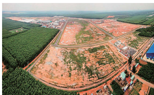
ロンドゥック工業団地インフラ工事パッケージP-1
