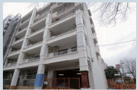
BIDフレーム工法施工状況
