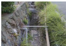
『ジオポリマー』とセメントコンクリートを敷設した排水溝
