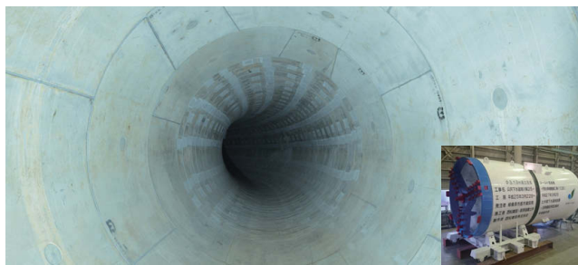
境川第25-1雨水幹線整備工事(1工区)
