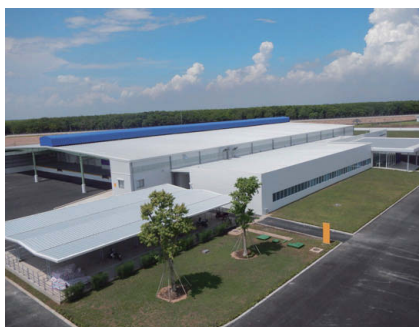
パラマウントベッドベトナム 組立工場新築工事
