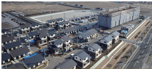
下増田地区防災集団移転促進事業 移転先団地造成工事
