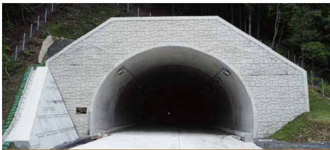
那智勝浦道路金剛寺トンネル工事
