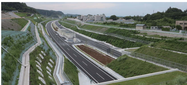
さがみ縦貫角田三栗山地区改良(その3)工事
