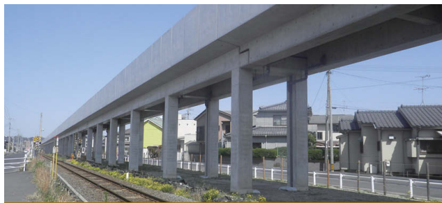
谷山高架陣之平BI新設他3
