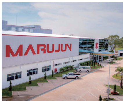
タイ丸順新工場建設工事
