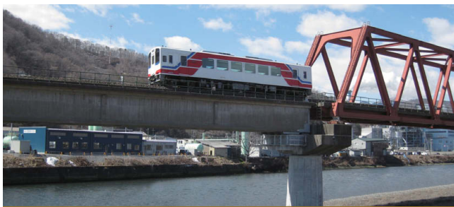
三陸鉄道南リアス線 吉浜・釜石間災害復旧工事
