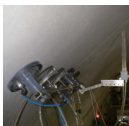
コンクリート表層品質調査
