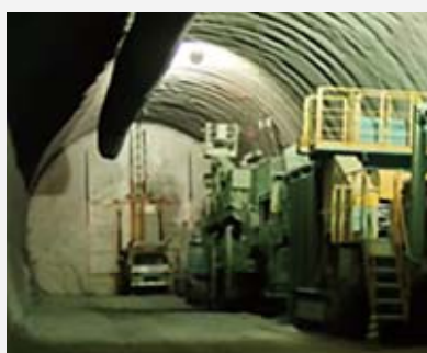
移動式発破防護バルーン使用状況
