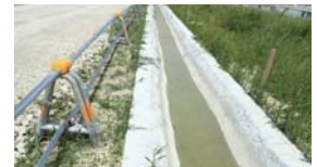
施工エリア外周部雨水側溝
