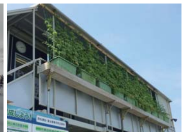
グリーンカーテン設置
