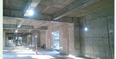
工所用仮設照明にLED照明使用
