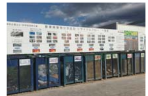
写真掲示によるゴミの分別を工夫した現場
