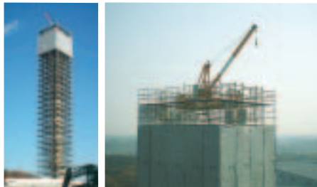
八千代市の旧3号焼却炉解体等工事
