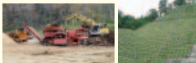
「根をリサイクル工法」で、伐木材をチップ化し、のり面緑化に再利用した
