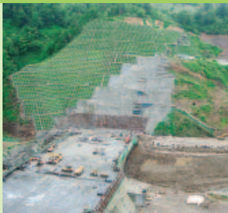
最盛期を迎える 徳富ダム工事現場の様子
