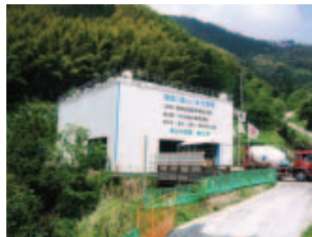
防音ハウス全景
