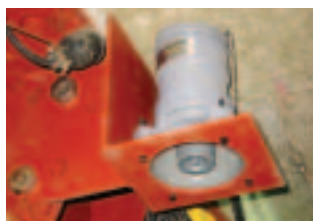
作業室内水位の連続監視システムの導入
