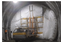
④展開完了 ⑤発破 ⑥収納開始
