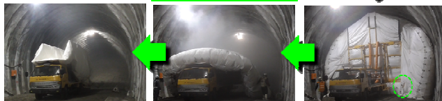
⑨収納完了・撤収 ⑩フレーム収納 ⑦ファスナー開放
