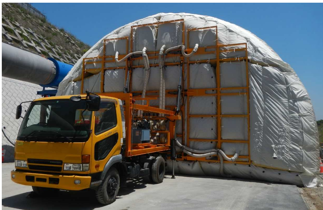
移動式発破防護バルーンの全景
