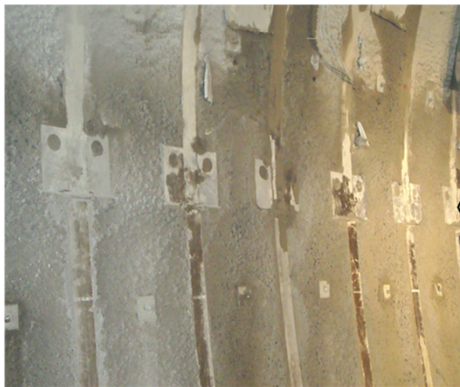
下半吹付け、ロックボルト終了
