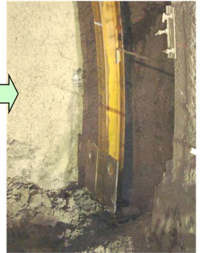
治具設置完了
