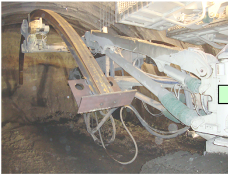
ウイングプレート付鋼製支保工を搬入
