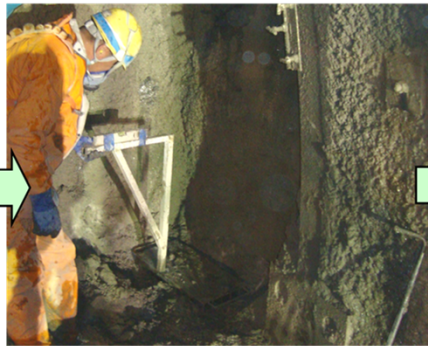
ベースプレートの敷設
