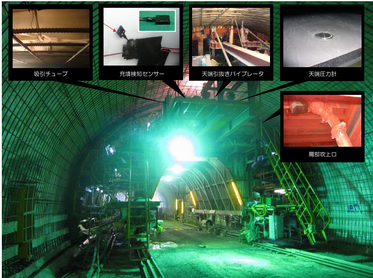
近畿自動車道紀勢線後呂地トンネル工事（国土交通省近畿地方整備局）
