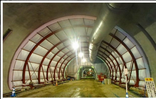
■コンクリート用バルーン 東日本大震災後の復興道路工事に適用(宮城県)
