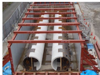
大型土槽全景（先行トンネル設置状況）
