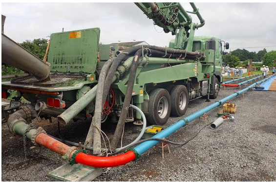
ポンプ圧送試験 (水平換算150m) 24-18-20N (スラグ70%置換)
