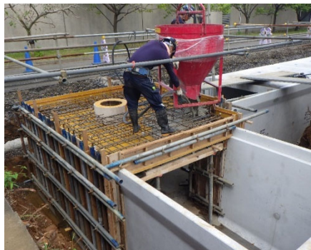
ボックスカルバート [側壁・頂版] 24-18-20N (スラグ70%置換)
