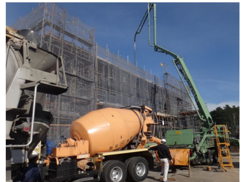
建屋屋上パラペット部 (12月施工) 27-18-20H (スラグ70%置換)
