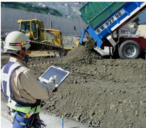
工事名: 嘉瀬川ダム副ダム建設工事 企業先: 国土交通省 九州地方整備局 他3件
