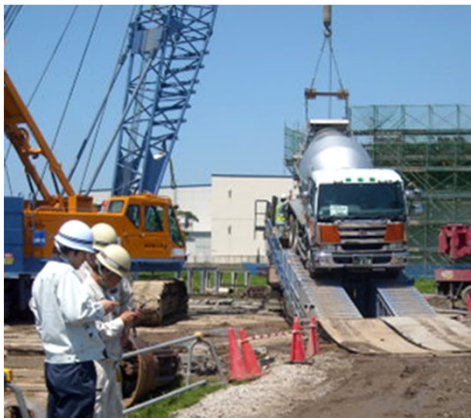
工事名: 北陸新幹線、富山水橋田伏高架橋 企業先: 鉄道建設・運輸施設整備支援機構 他12件
