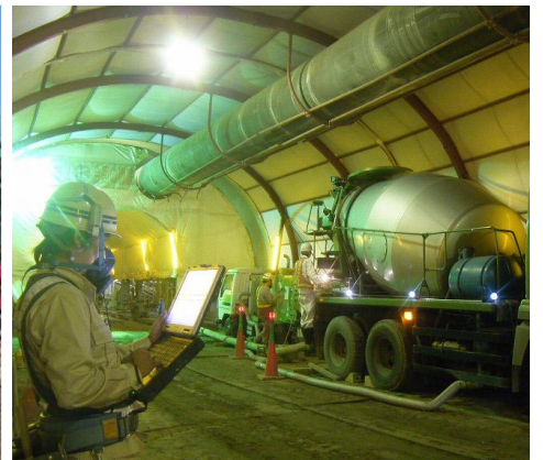
工事名: 能越道 氷見第8トンネル工事 企業先: 国土交通省 北陸地方整備局 他2件
