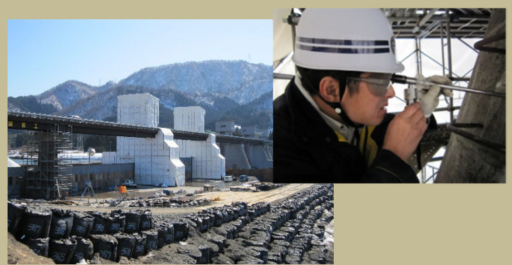
阿賀野川頭首工（堰柱）
