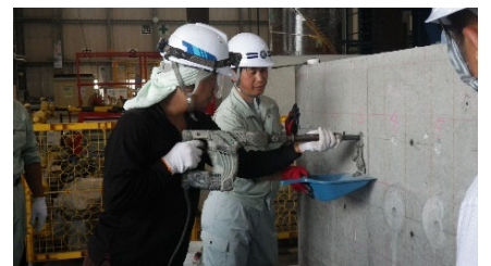
「サイトフィットネイリングバー (SNB) ®」の打込み
