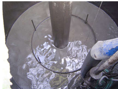
コンクリート打設
