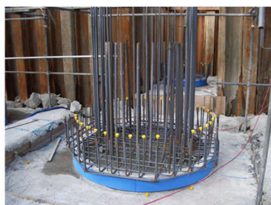
発泡ポリエチレン設置
