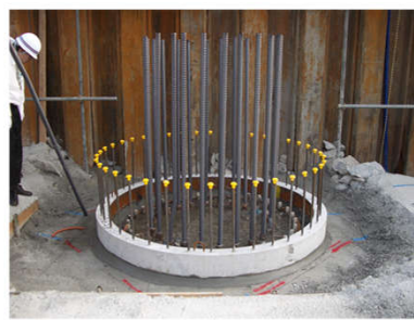
モルタル打設・引張定着筋挿入
