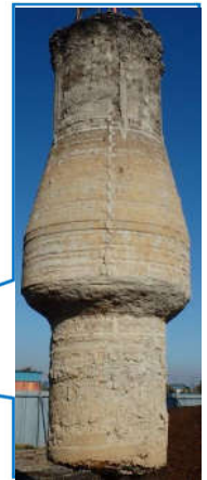
Me-A工法による杭体
