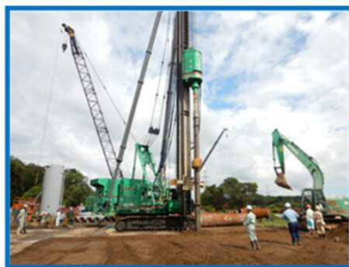
掘削（二重管杭一体化用）
