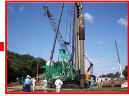
二重管杭建込み
