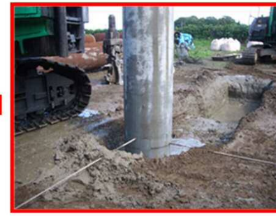
杭心ずれ確認
