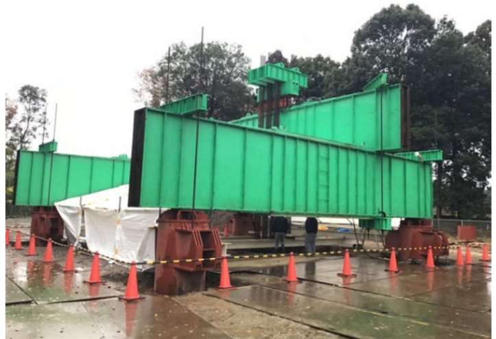
構造性能を確認するための載荷試験状況
