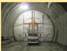
【移動式発破防護バルーン】
