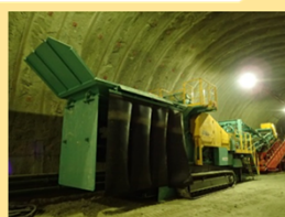
【自走式クラッシャー】 切羽進行に追従して 最大20m程度前進可能
