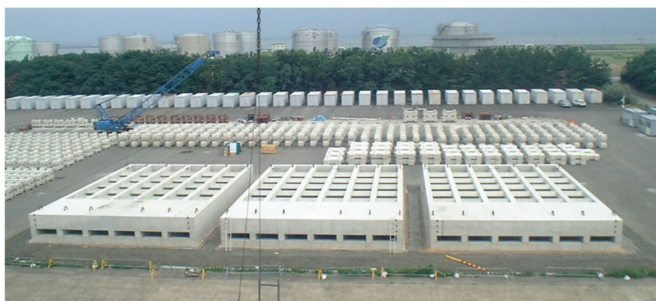
陸上でのRC中空構造物の製作状況
