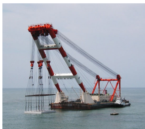
起重機船によるRC中空構造物の据付状況
