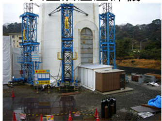
自昇降養生、ジャッキ
