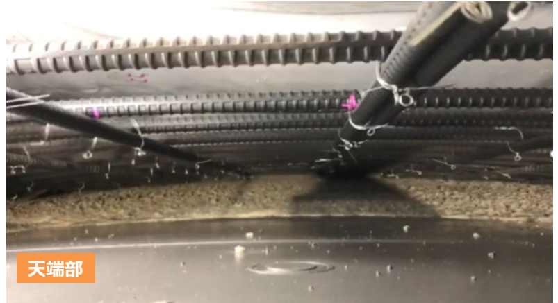
▲覆工コンクリートの流動状況
