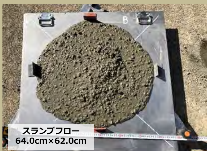
再アジテート後 (再生覆工コンクリート製造完了)
