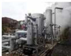
屋外設備: 熱交換器・汽水分離器・ 蒸気放出装置
