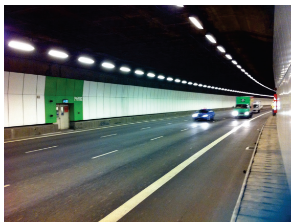
写真-2 KPE トンネル
