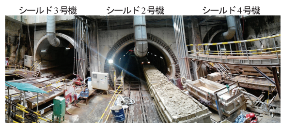
写真－6 3台同時掘進状況
