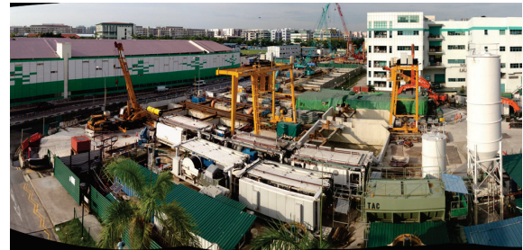
写真－5 発進立坑基地全景
