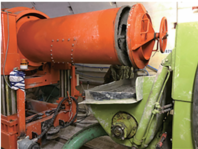
写真-5 アジテーターカーから定置式ポンプへの投入状況
