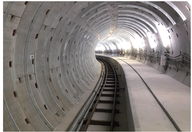
写真-6 インバート工施工完了
