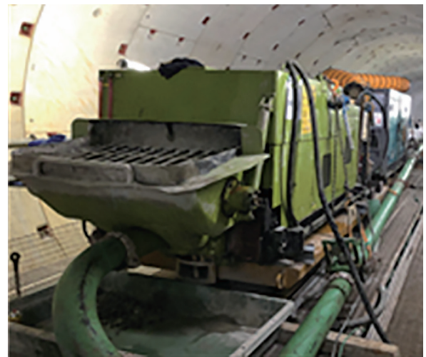
写真-5 アジテーターカーから定置式ポンプへの投入状況
