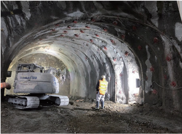
写真一2 避難連絡坑掘削状況
