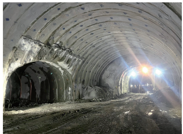
写真一5 避難連絡坑交差部
