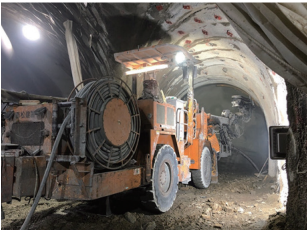
写真一3 避難連絡坑建込み状況
