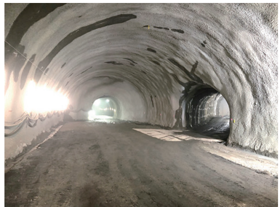
写真一9 吹付覆工施工完了
