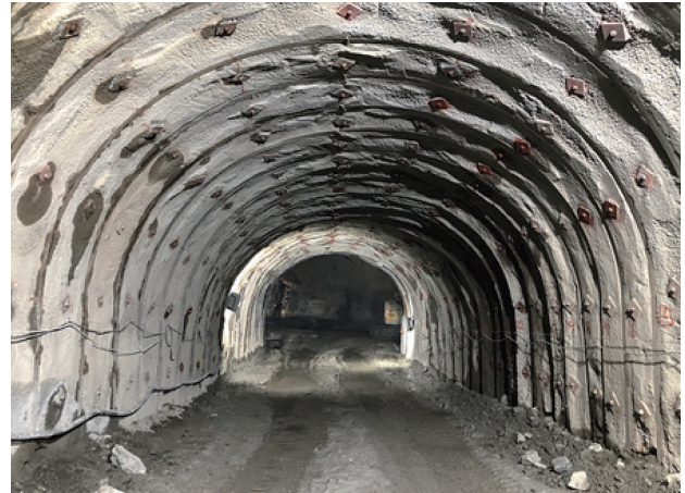
写真一4 避難連絡坑施工完了
