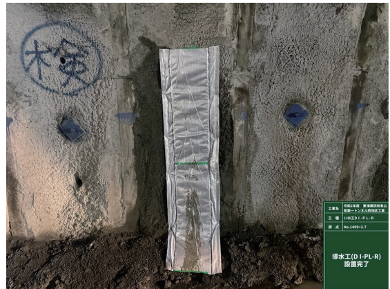
写真一7 導水工施工完了
