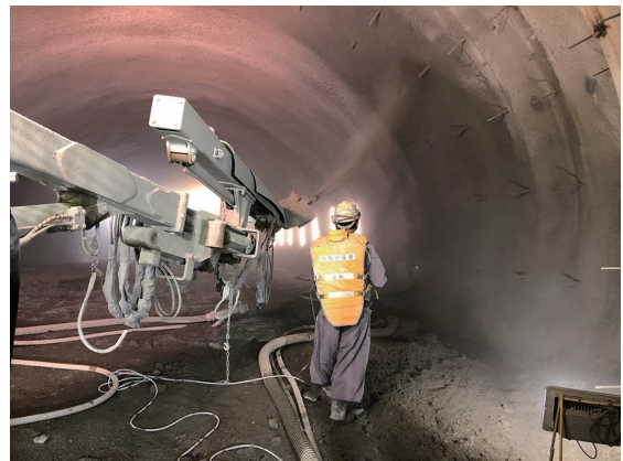
写真一8 吹付覆工施工状況
