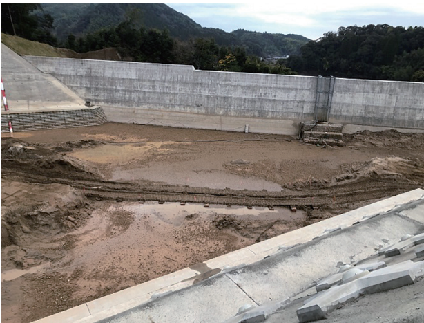
図-9 H形鋼+鉄板道路
