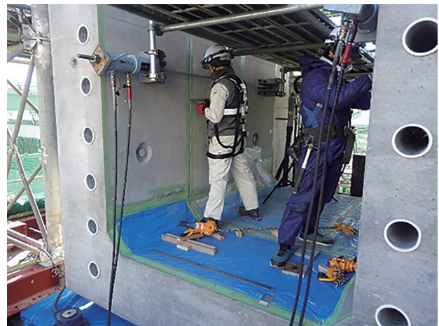
写真-2 引き寄せ状況
