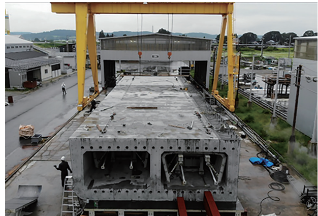
写真-1 セグメント製作状況
