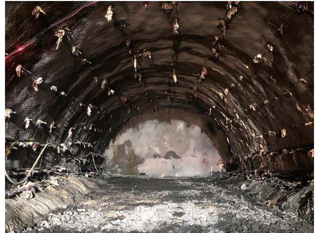
写真-10 変状対策完了
