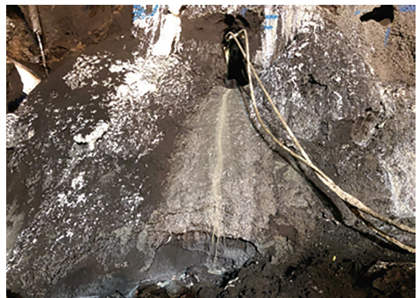
写真-3 シリカレジン未反応状況
