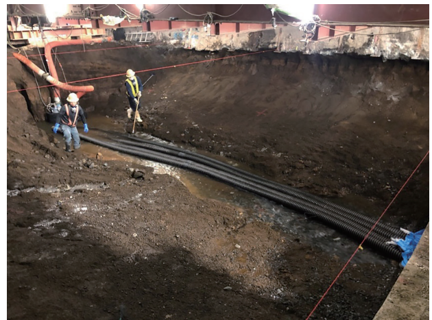
写真一八 仮中央排水管設置状況
