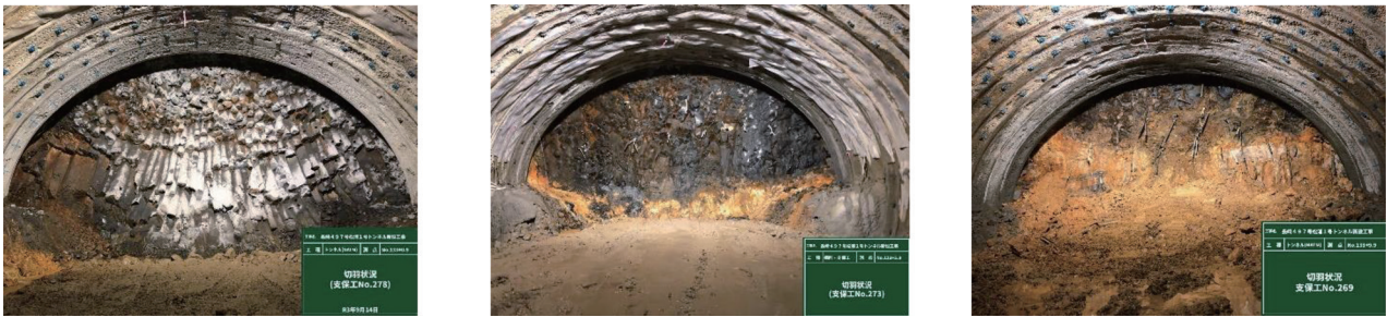
図一10 推定される地質境界と周辺の実際の切羽写真
