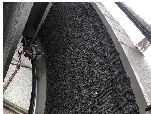
写真二 コリジョンジェット工法による切削状況
