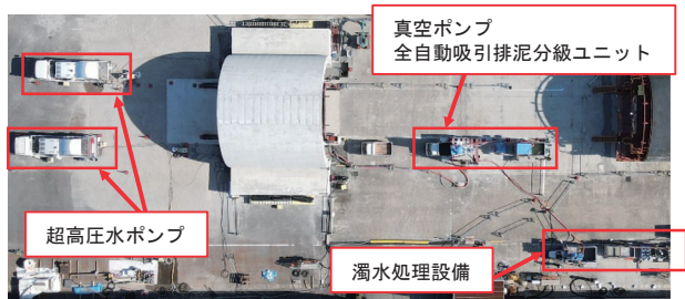
写真-4 WJ 切削設備配置状況
