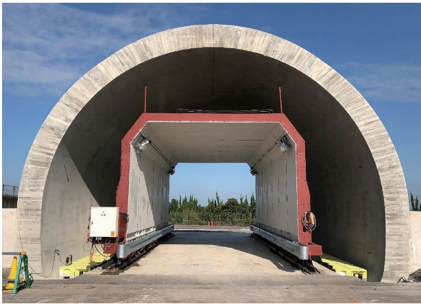
写真一六 防護工設置完了全景
