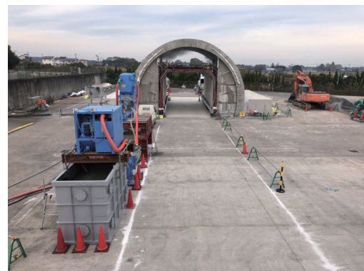
写真一 WJ切削試験全景
