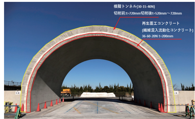
写真-10 再生覆工コンクリートの打設完了
