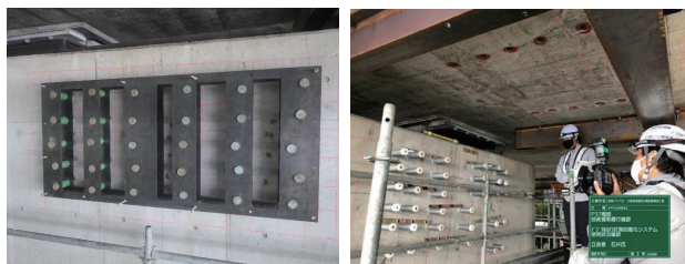
写真-3 アンカーボルト定着精度の確保
