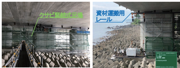
写真-2 仮設備全景
