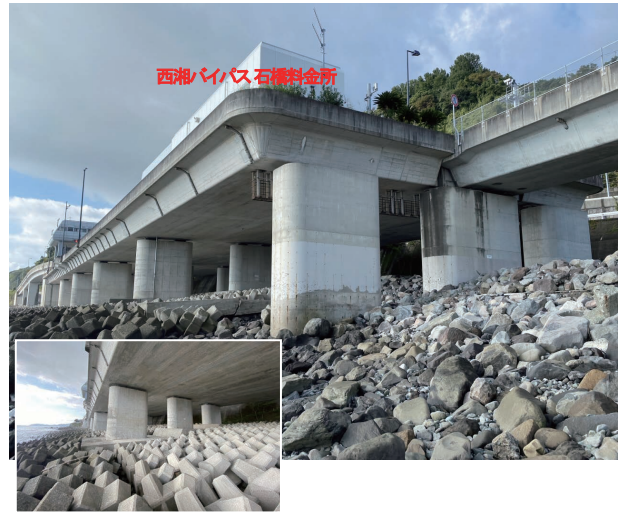
写真-1 施工箇所全景と消波ブロック
