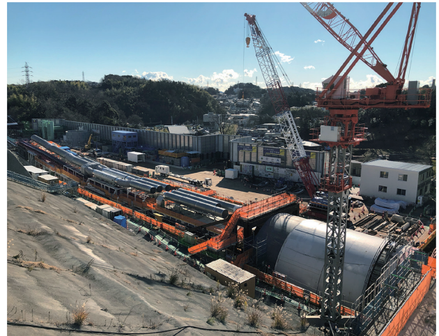
写真-2 シールド発進時後続台車
