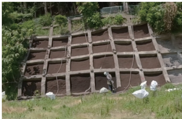
写真-3 法枠への吹付後の様子
