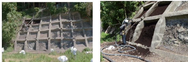
写真二 試験法面と法枠（左）、吹付施工の様子（右）
