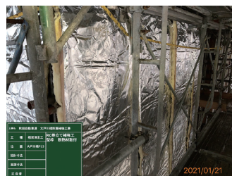
写真四 保温・給熱養生
