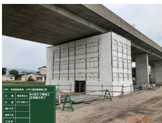
写真三 シート張り防護
