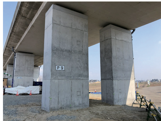
写真二 RC 巻立て補強工
