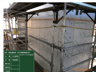
写真五 気泡緩衝シート養生
