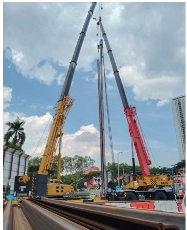
写真一 ハット型鋼矢板打設状況
