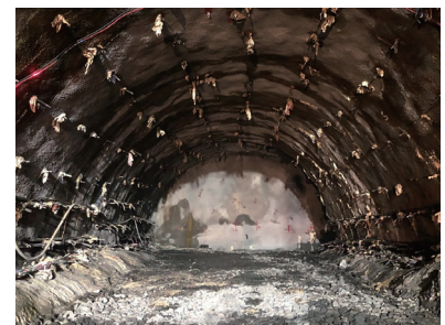
写真一 4 変状対策完了
