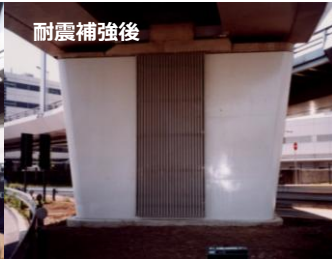
橋梁下部工耐震補強工事
