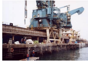
塩害対策のための改修および電気防食工事
