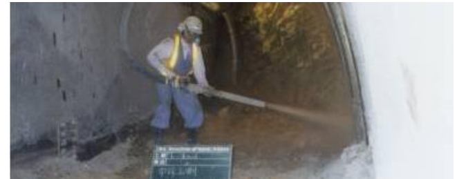
ずい道改修工事
