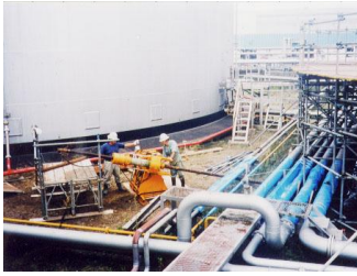
既設タンク液状化対策工法
