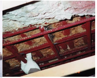
塩害対策のための改修および電気防食工事
