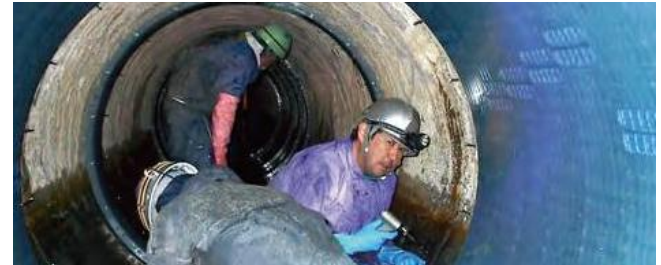
「3Sセグメント工法」による下水道改修工事
