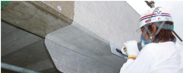
「P.P.ネットライニング工法」による剥落防止対策
