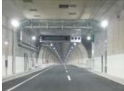
首都高速中央環状新宿線 SJ46工区 (2) トンネル（東京都）
