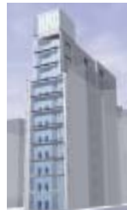
商業地の事務所ビルや板状の中高層集合住宅
