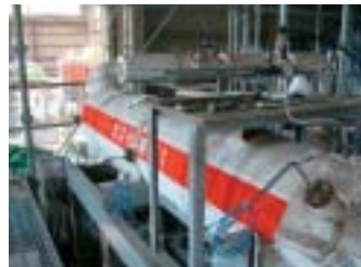
ガス化装置 汚染された土壌を過熱蒸気とヒーターで600℃まで加熱して、PCBなどを揮発させる部分
