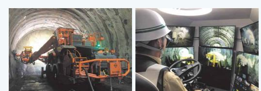
西松建設が2018年から取り組んでいる「山岳トンネル無人化施工システム(Tunnel Remote Operation System)」。同システムは、トンネル掘削工事の基本となる自由断面掘削機、ドリルジャンボ、ホイールローダー、計測台車、セントルなどの作業用機械と、それらを制御する遠隔操作システムから構成されます。
