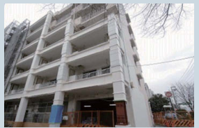
BIDフレーム工法施工状況
