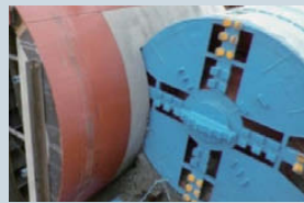
GFRGセグメント切削実証実験
