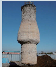
中間掘場所打ちコンクリート杭(Me-A工法)
