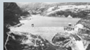
1946年(昭和21年) 岩手県北上川水系、石淵ダム、 日本初のロックフィルダムの 施工。
