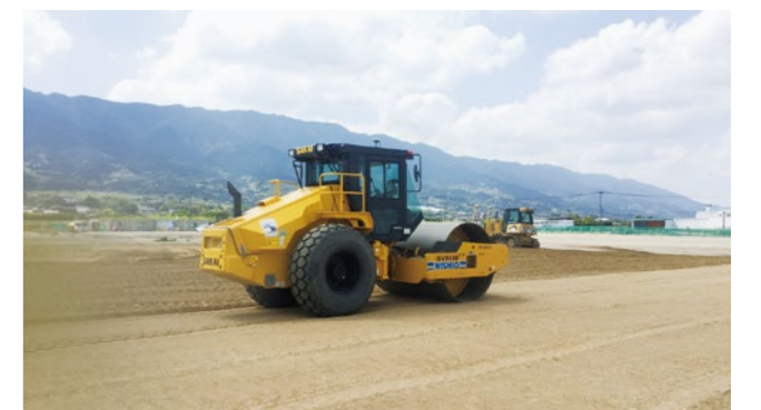
ICT施工 (GNSSローラー締固め管理) による施工状況
